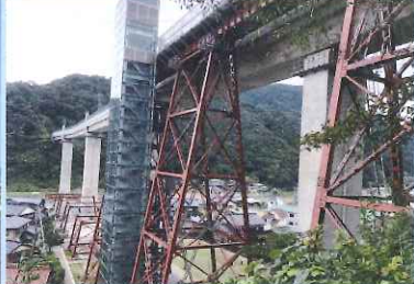
余部橋梁（兵庫県香美町）/ 明治45年竣工
