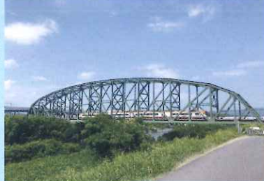
澁川橋梁（京都府京都市）/ 昭和3年竣工
