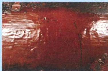
余部橋梁の橋脚に陽刻された「PENCOYD」/ 所蔵：舞鶴工業高等専門学校 ペンコイドとは、アメリカンブリッジ社の工場名 / 明治45年竣工
