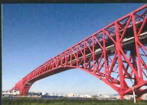
港大橋 (大阪府大阪市)
