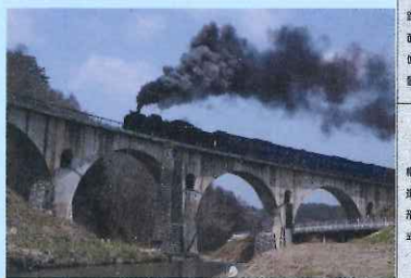
アーチ橋（上路鉄筋コンクリート充腹 バランスド・アーチ）/ 宮守川橋梁 （岩手県遠野市）/ 昭和18年竣工 / 提供： 遠野市観光交流課
