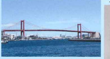
若戸大橋（鋼3径間2ヒンジ補剛トラス吊橋） / 福岡県北九州市 / 全長627m/ 日本の長大橋の先駆け / 昭和37年竣工 / 提供：北九州市道路公社
